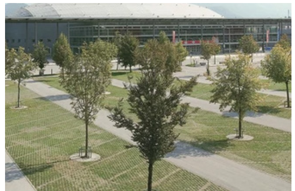
Entsiegelter Parkplatz bei der Messe Salzburg (Quelle: MZS/ Kaindl-Hönig)
