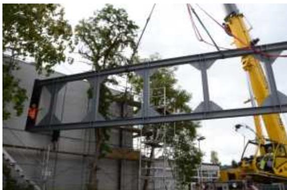
Einbau von Stahlträgern für verbesserte Erdbebensicher
