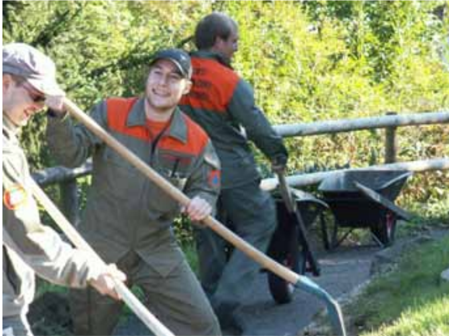
Die Zivilschützer bei Instandstellungsarbeiten
